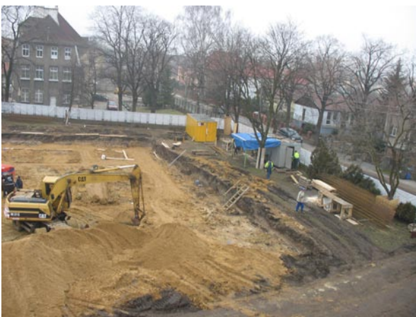
początek prac budowlanych
